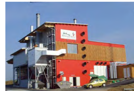
Das Biomasseheizkraftwerk Waldmünchen (Betreiber WBV und BaySF) ist Partner des Netzwerkes.
