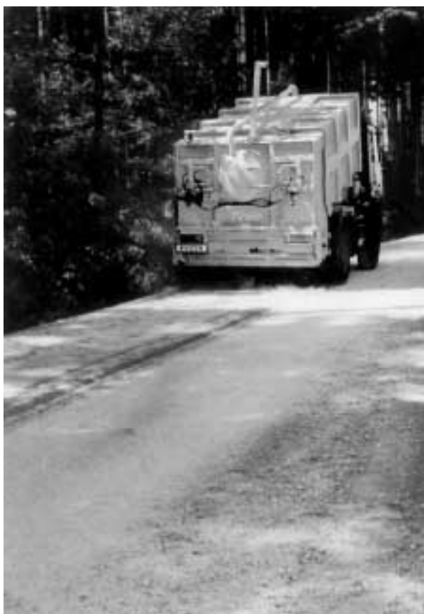
Zementverteilung mit einem Dosiergerät
