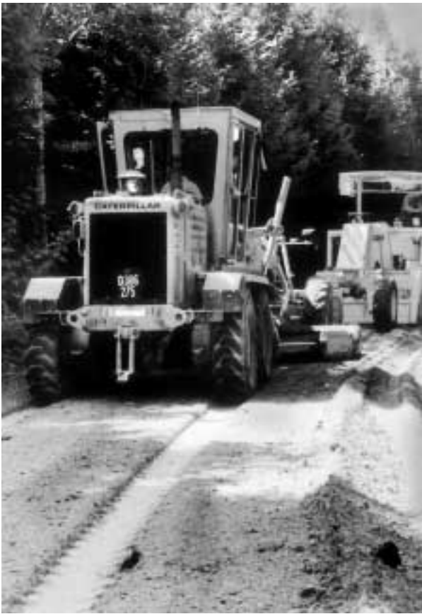
Profilgerechte Verteilung der frischen Stabilisierung mit einem Grader
