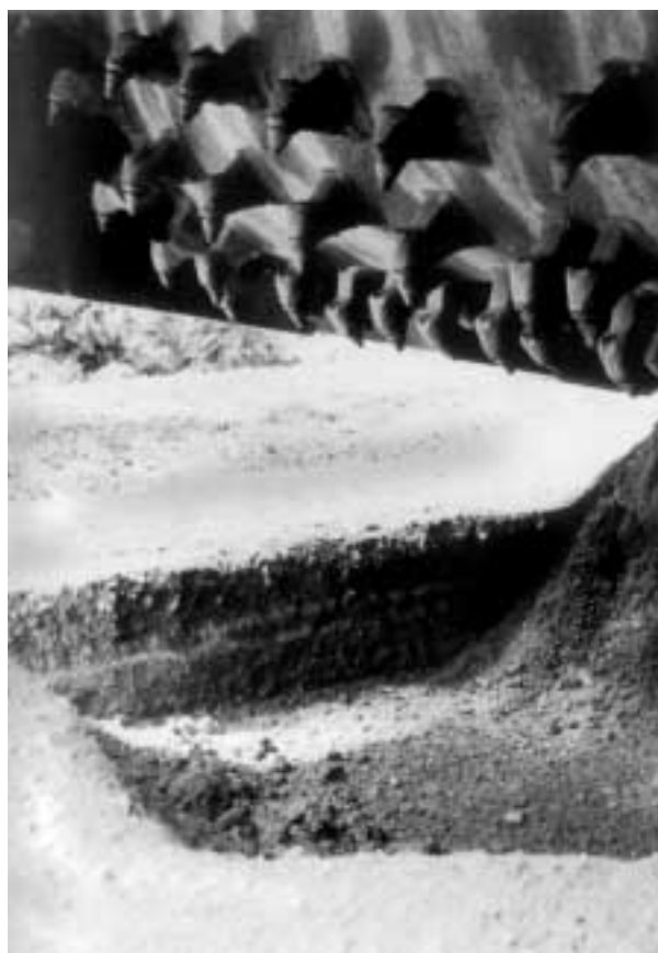
Tieffräsung im Detail
