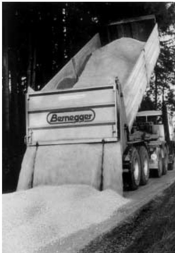
Tragschichtverstärkung durch Aufbringen von Zusatzmaterial
