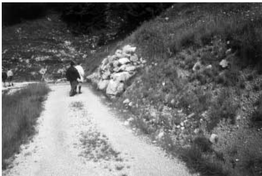
Neuer Erschließungsweg auf die Staffelalm (Gemeinde Jachenau) mit naturnaher bergseitiger Böschungssicherung und aufkommender Wiederbegrünung
