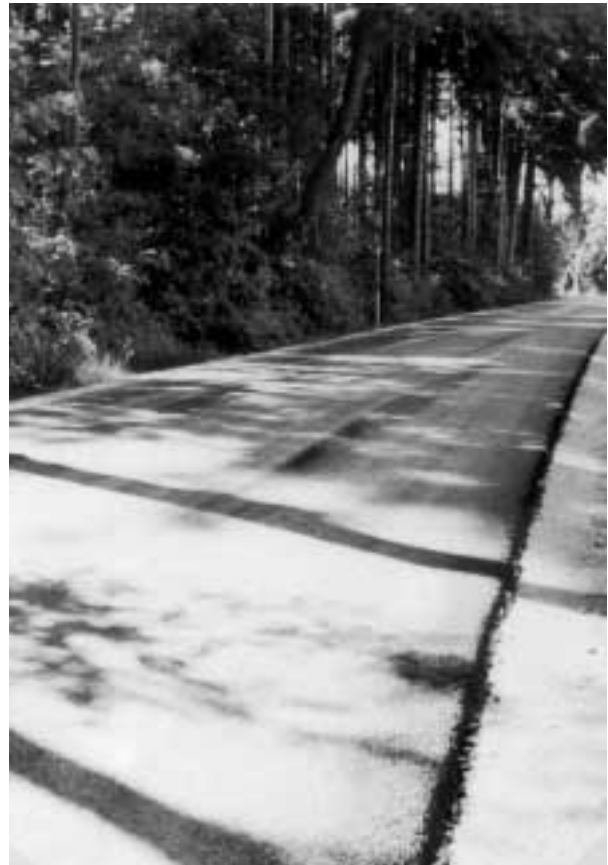
Fertige Stabilisierung mit Asphalttschicht
