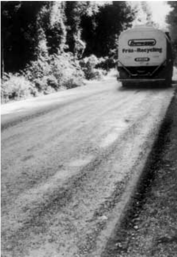
Aufbringen des Verdunstungsschutzes
