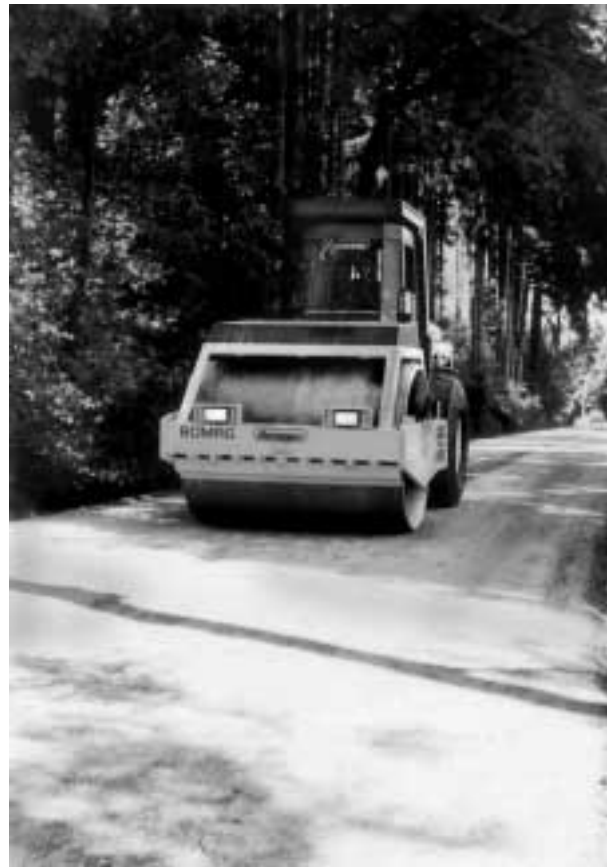
Verdichtung des Fräsgutes
