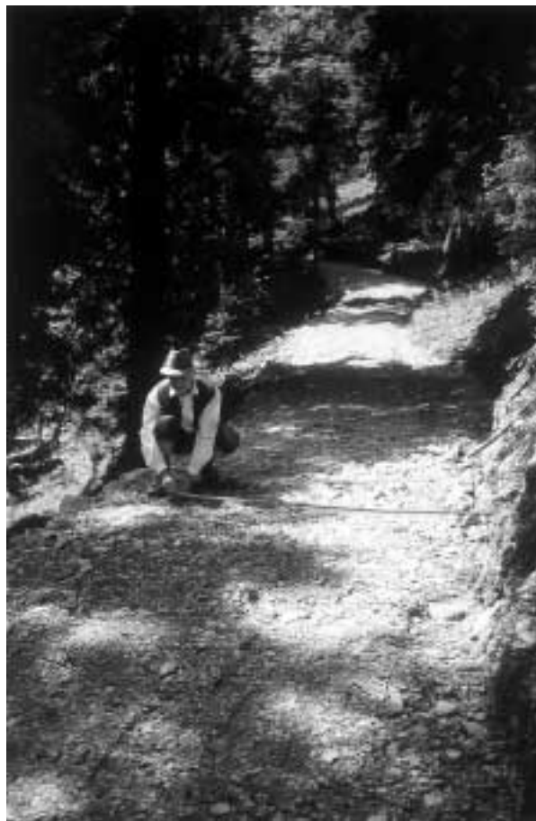
Neuer Erschließungsweg zur Rauheckalm (Gde. Kreuth), mit 2,50 m Breite gerade noch schleppergerecht
