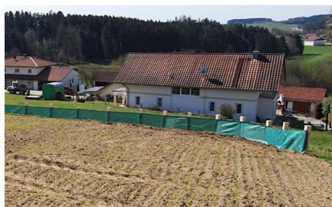
Bild 5: Fertig aufgestellter Sedimentfangzaun (Foto: Theresa Scherm)
